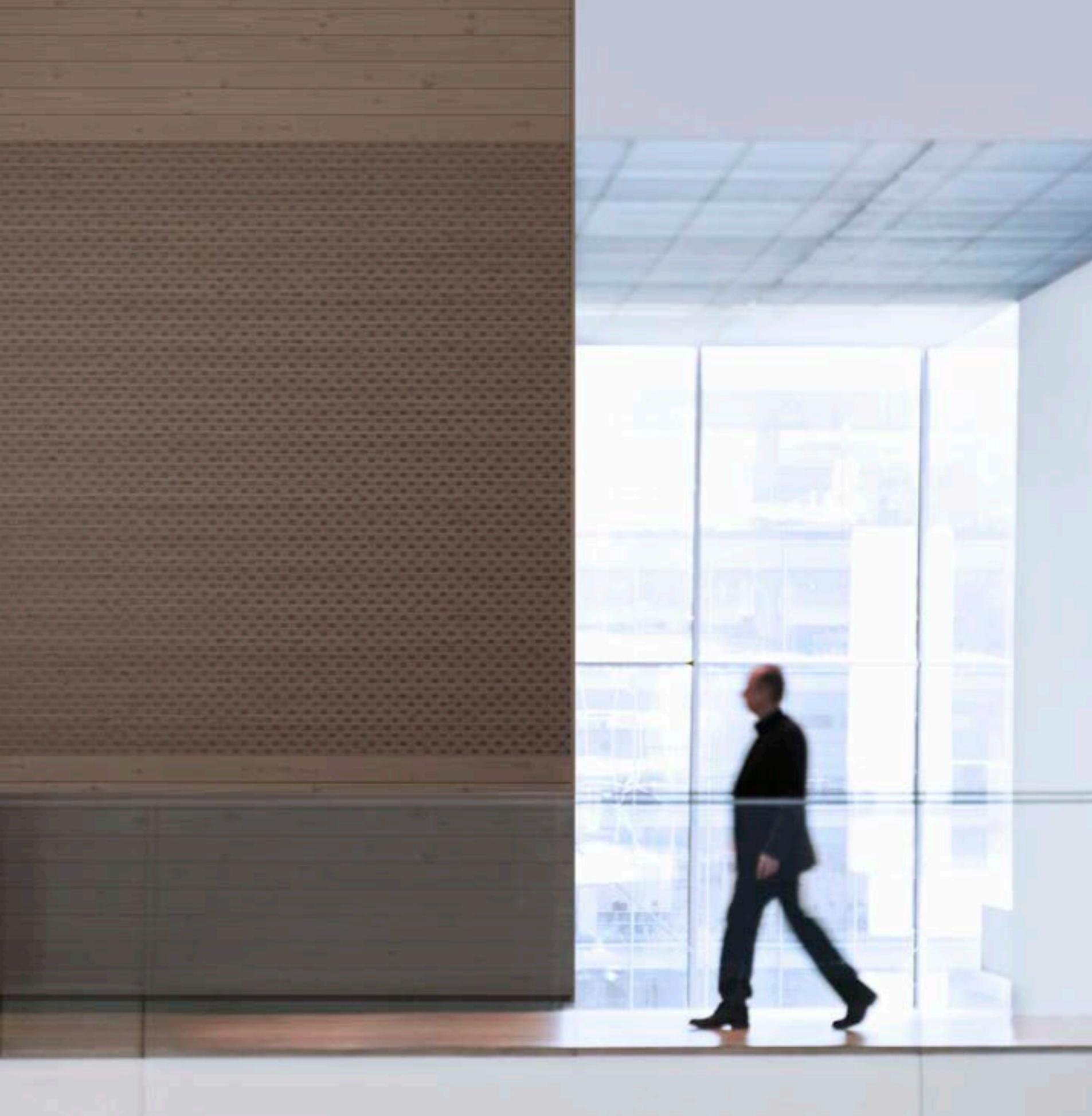
Perfil acústico R9T64, en combinación con perfil 528, ancho lama 145. Barniz seda Cappuccino / Acoustics profile R9T64, in combination with profile 528, slat width 145. Cappuccino Silk varnish.
